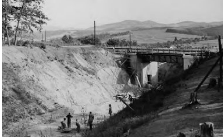
Jormannsdorf: Bau der Eisenstädter Bundesstraße, Unterführung (Eisenbahnbrücke), 1950.
