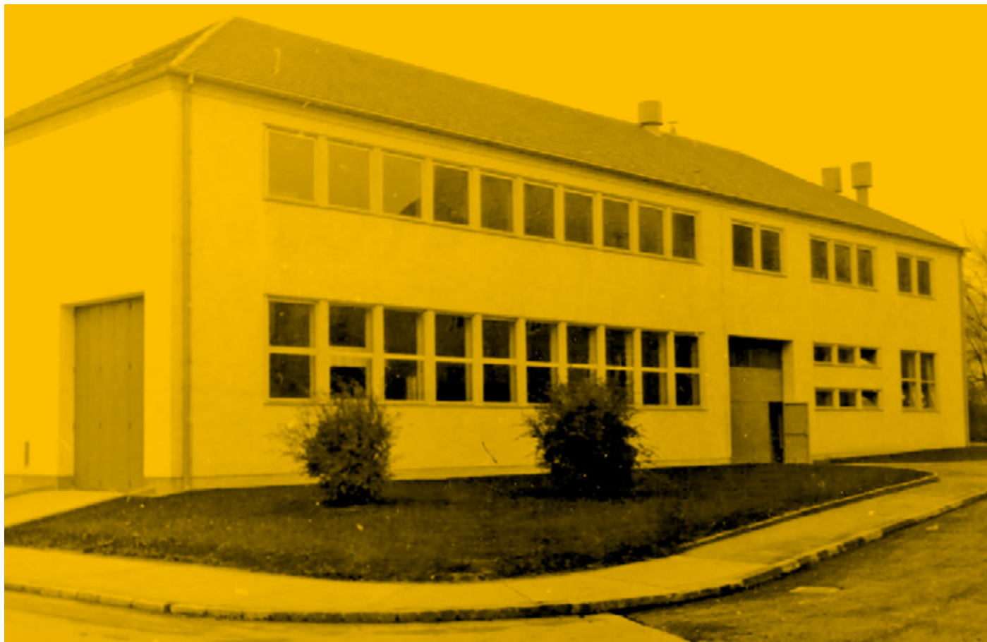
Ehemaliges WIFI-Gebäude in Eisenstadt, Ansicht Kurzwiesenweg.
