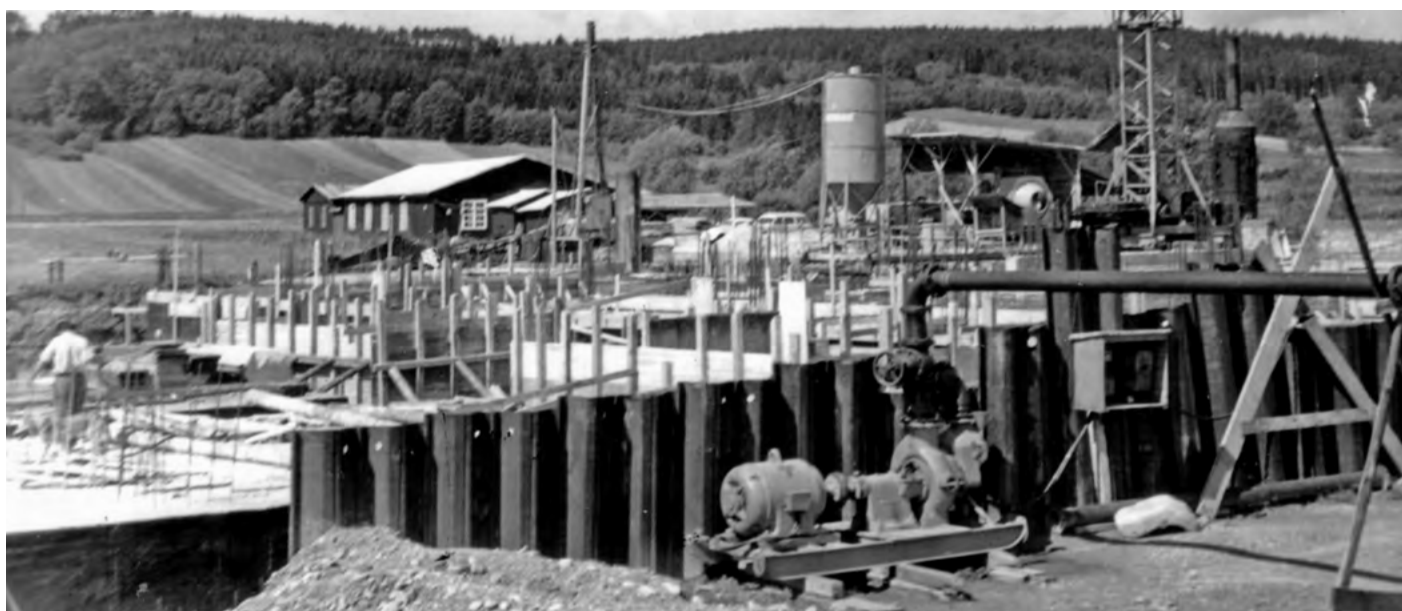
Baustelle Fernheizkraftwerk Tauchen.
