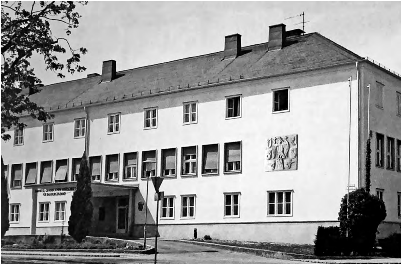
Das fertiggestellte Handelskammergebäude 1951.
